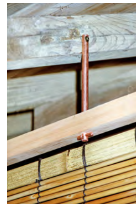
ビス留め施工の写真です
